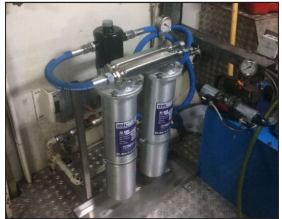
AL600 Doppelsystem mit WS800 für Diesel am Hauptmotor. AL600 double system with WS800 for diesel on the main engine.
