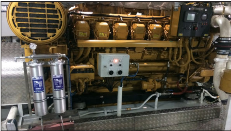
AL600 Doppelsystem für Öl an einem Generator. AL600 double system for oil on a generator.
