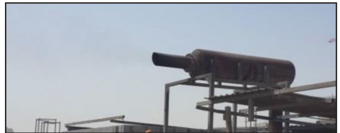
Nach der Installation der micfil Filter. After the installation of the micfil filters.
